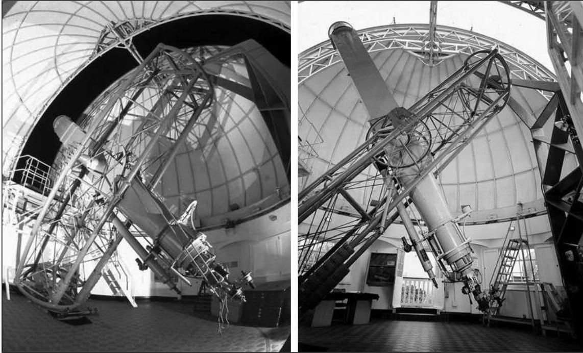
Figura 6- Refractor de Greenwich: 71 cm  $f/12$ .
