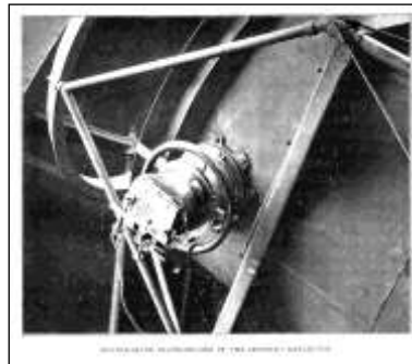
Figura 7- Sistema de guiagem no foco newton do reflector de Crossley. Observatório de Lick (ca. 1900).
