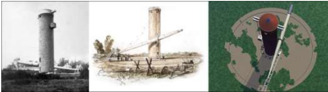
Figura 3- Telescópio de Craig (1852). Fotografia da época (esquerda) e reconstituição do telescópio (centro e direita).
