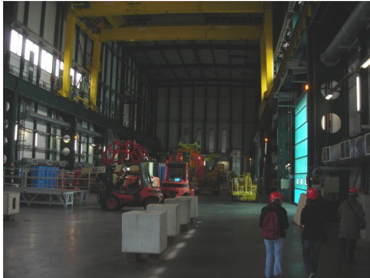
Intérieur de l'imposant bâtiment où fut construit puis descendu CMS. Posé sur des vérins, il sera abaissé afin d'être plus discret dans le paysage !
