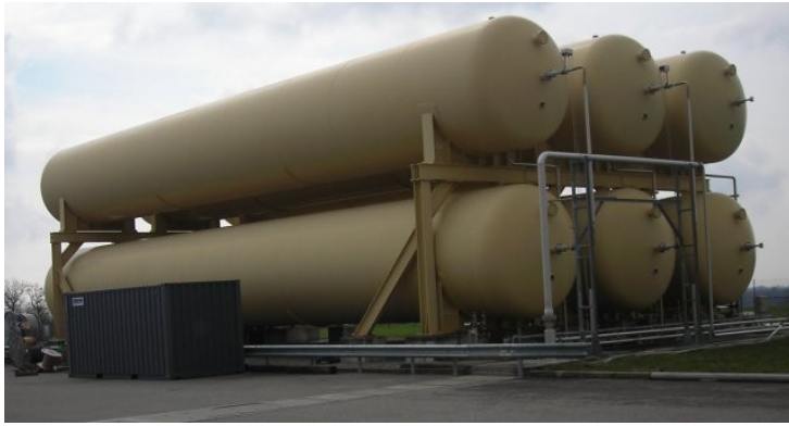
Quelques-uns des imposants réservoirs d'hélium liquide destiné à refroidir les 27 km de l'accélérateur
