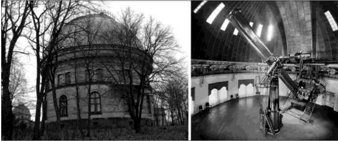
Figura 2- Observatório de Postdam: cúpula (esquerda) e refractor (direita) munido de duas objectivas (80cm f/15,25 - fotográfica e 50 cm f/25 - visual).
