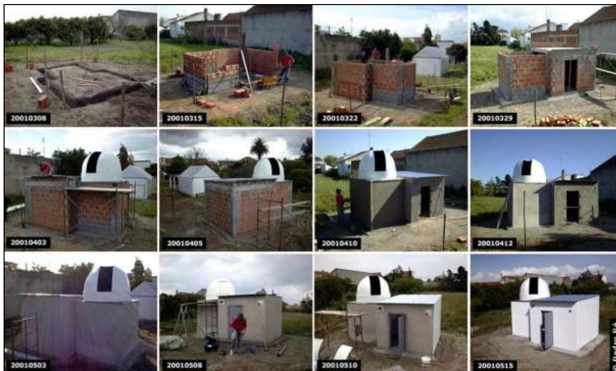
Figura 2- Fases da construção do observatório (20010308/20010515).
